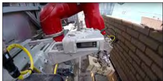
Рис. 2. Напівавтоматичний робот SAM компанії Construction Robotics [10]
